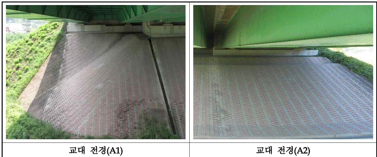
【사진 3.2.5】 교대 전경(대구)
