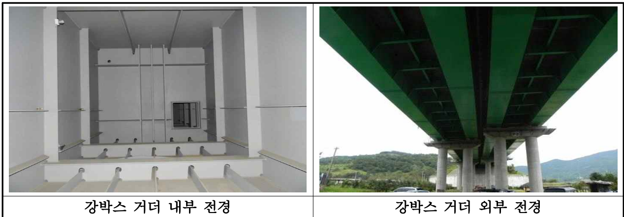
【사진 3.3.3】 강박스 거더 전경(부산)
