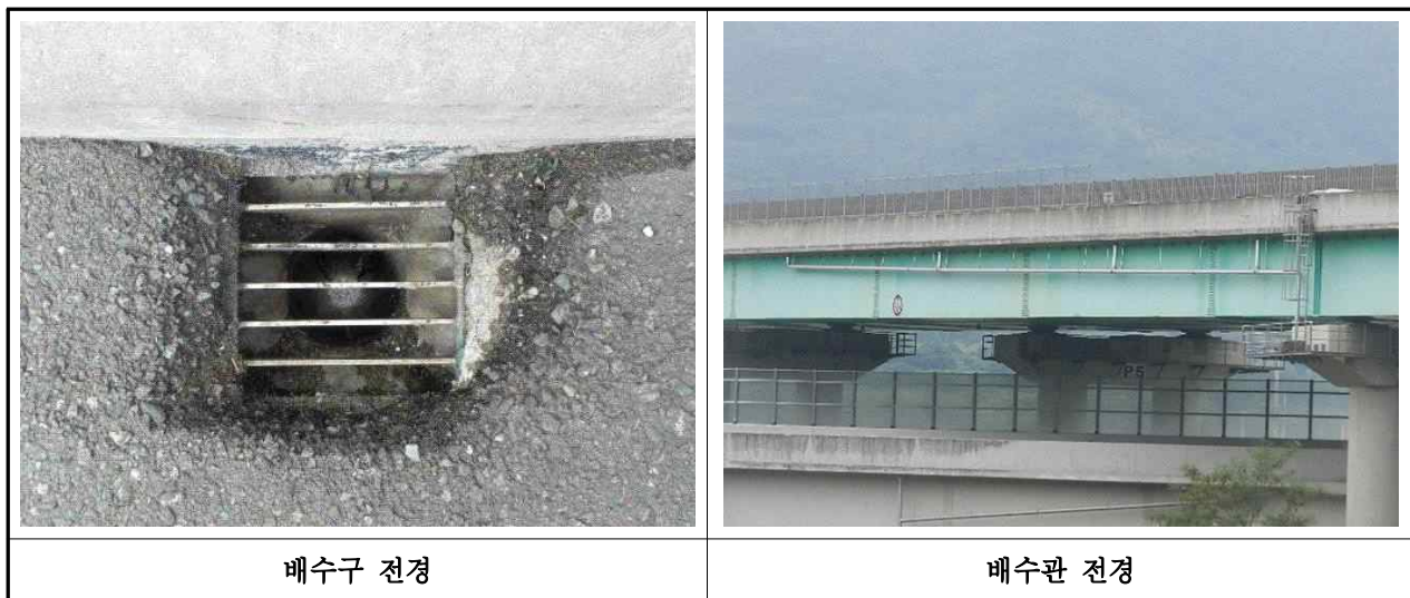
【사진 3.3.17】 배수구 및 배수관 전경(부산)
