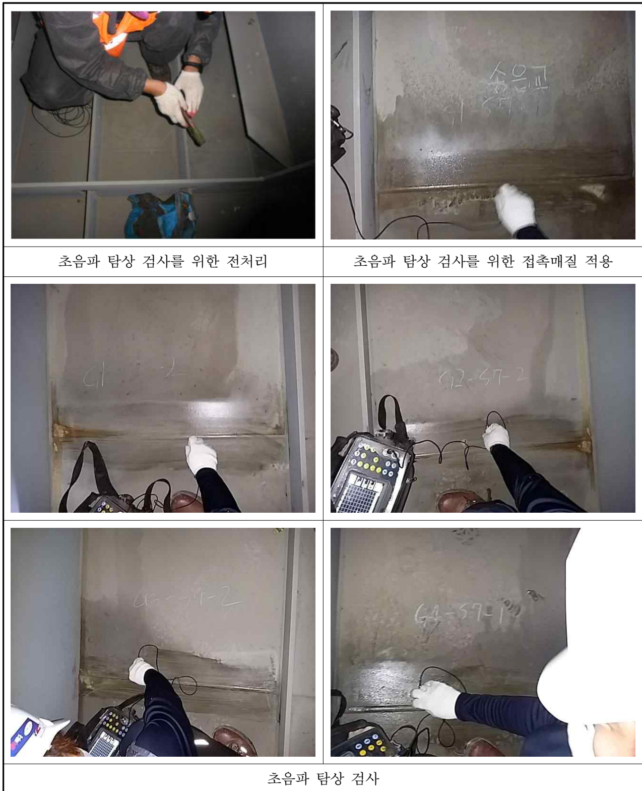
【사진 3.5.1】 강재 내구성조사 전경
