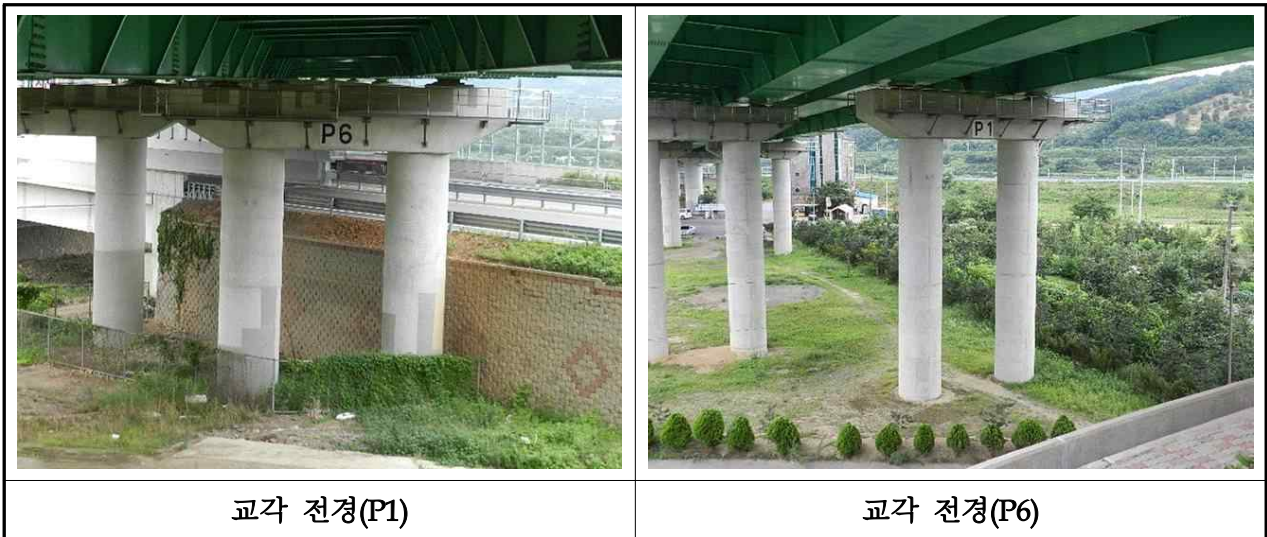
【사진 3.3.7】 교각 전경(부산)
