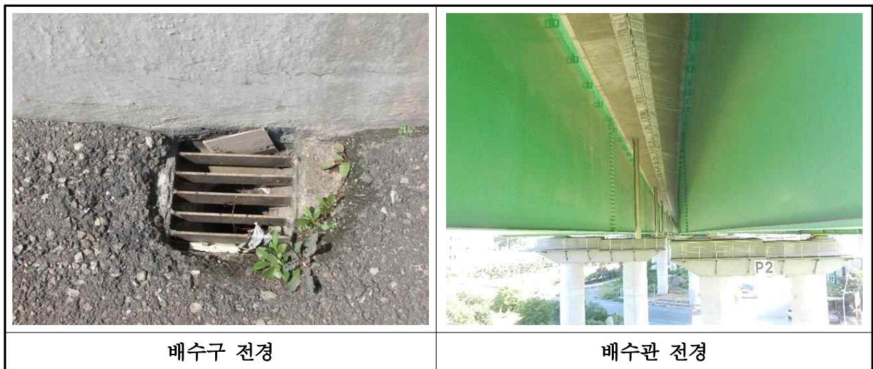
【사진 3.2.17】 배수구 및 배수관 전경(대구)
