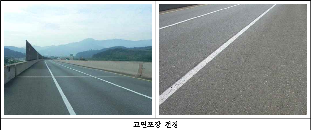
【사진 3.2.15】 교면포장 전경(대구)
