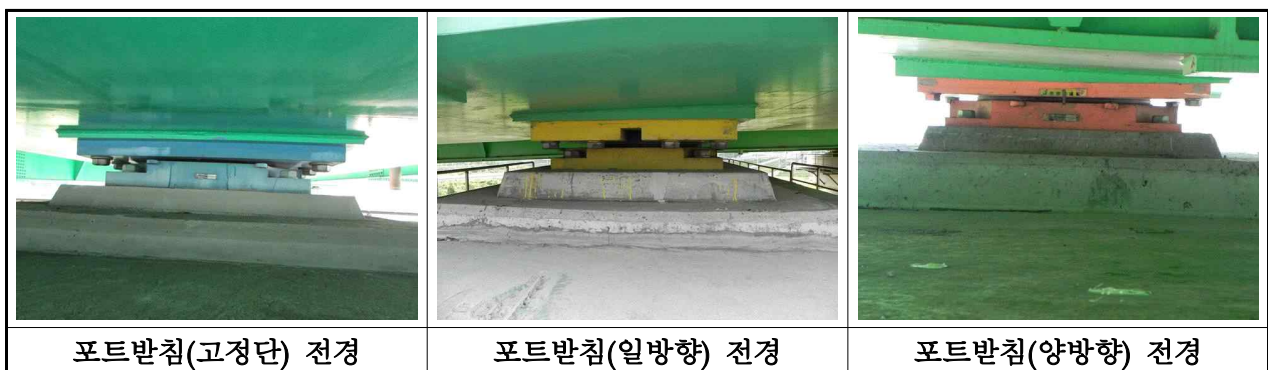
【사진 3.3.9】 교량받침 전경(부산)
