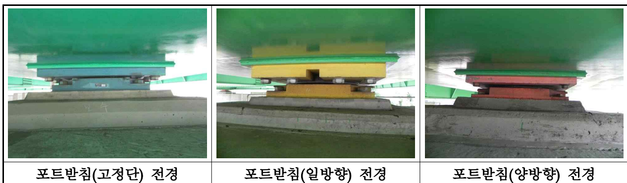
【사진 3.2.9】 교량받침 전경(대구)
