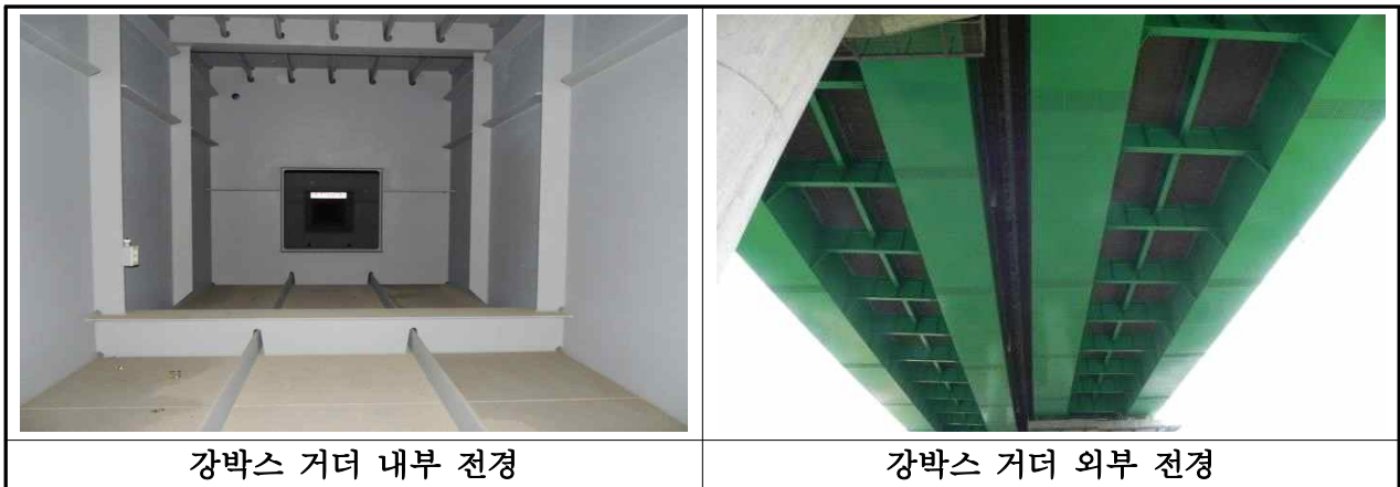
【사진 3.2.3】 강박스 거더 전경(대구)
