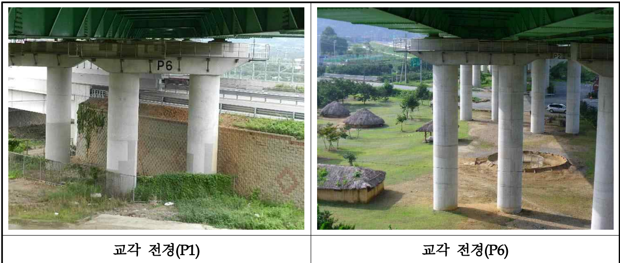
【사진 3.2.7】 교각 전경(대구)
