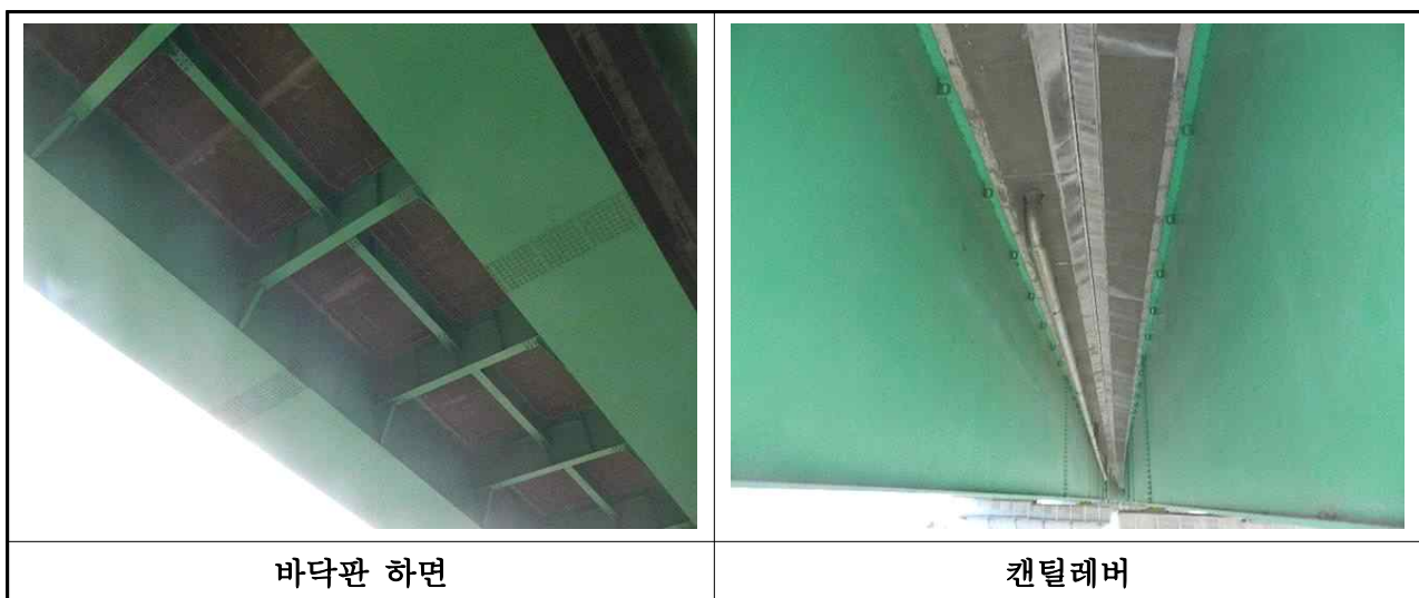
【사진 3.2.1】 바닥판 전경(대구)
